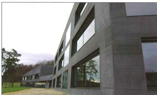
Les deux corps de bâtiment sont structurellement séparés par un balcon à ciel ouvert.
