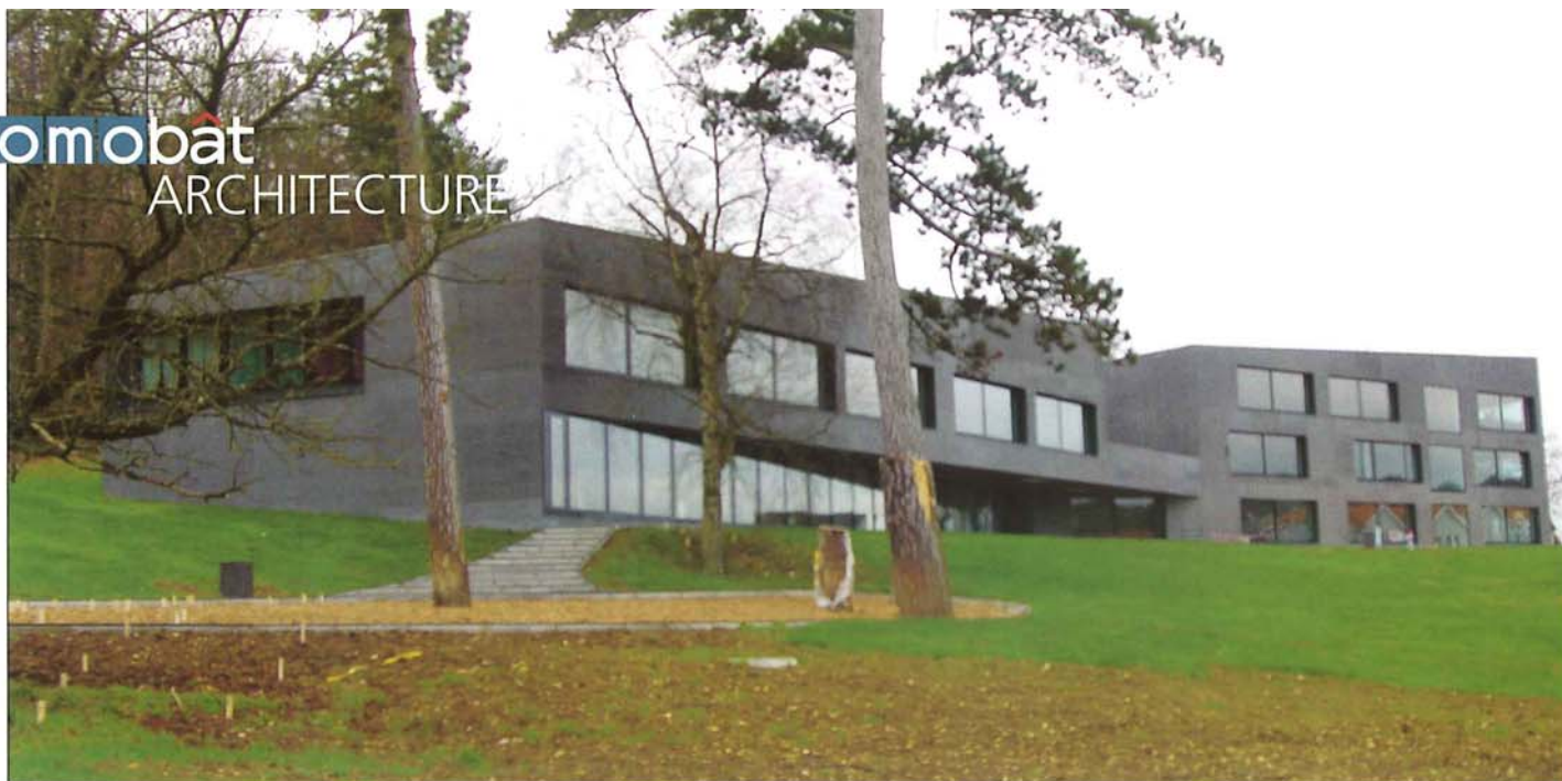
Vue générale de l'école de l'Oiselier: une grande partie des locaux sont orientés au nord, avec vue panoramique sur Porrentruy.
