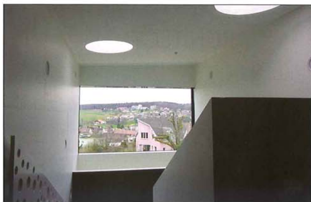
Les éclairages zénithaux font office d'exutoires de fumée. Ouvrables, ils permettent en été de rafraîchir la masse du béton durant la nuit.
