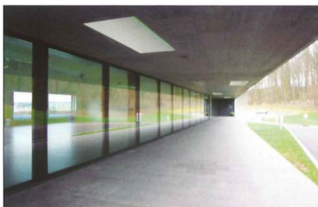
Accès à l'aula: les vitrages présentent un joint minimum avec la pierre, et n'ont pas de cadre de façon à obtenir un miroitement maximum.
